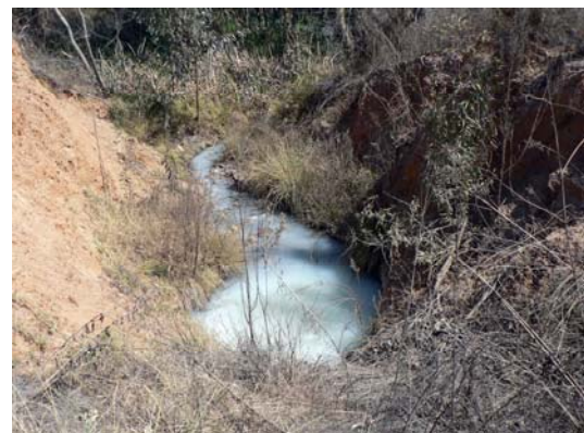
Effluent Dam out Flow
