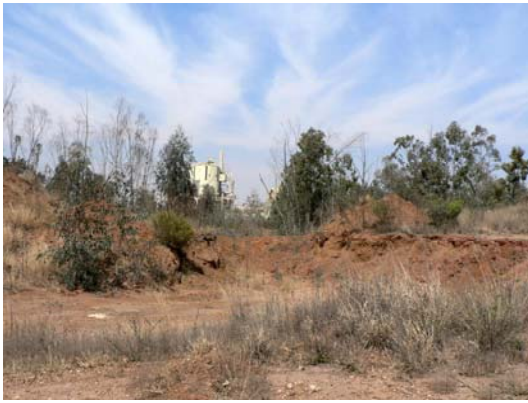
Effluent Dam Wall
